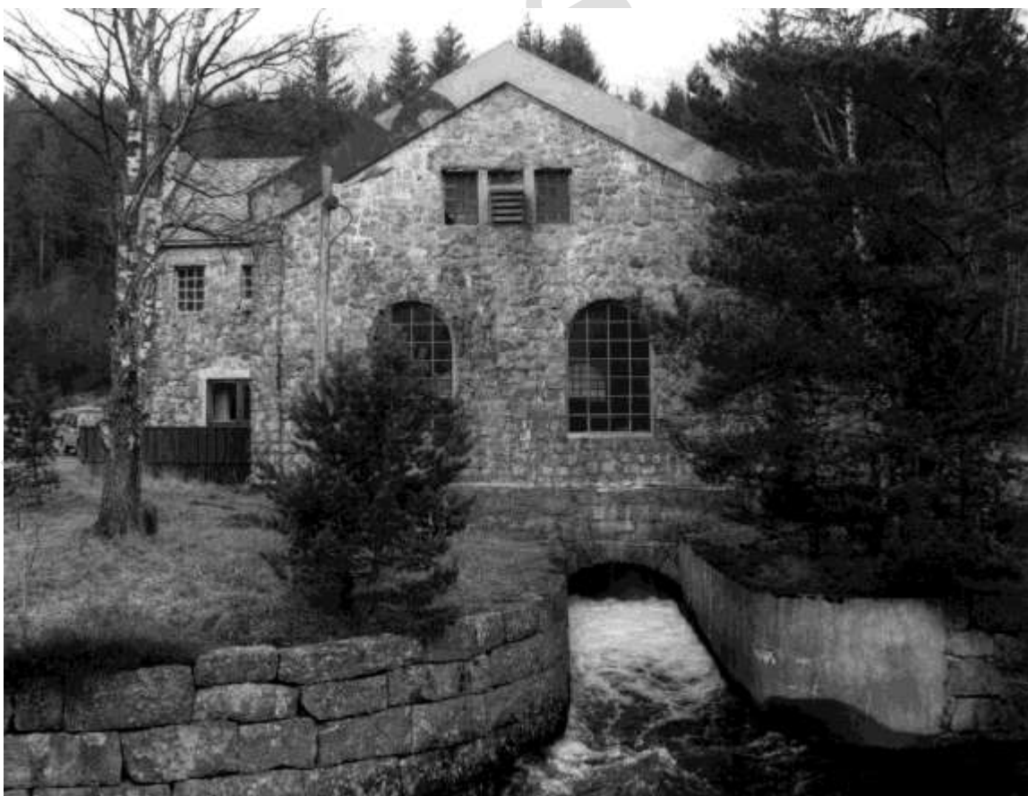
Kraftstasjonen i Dalen
